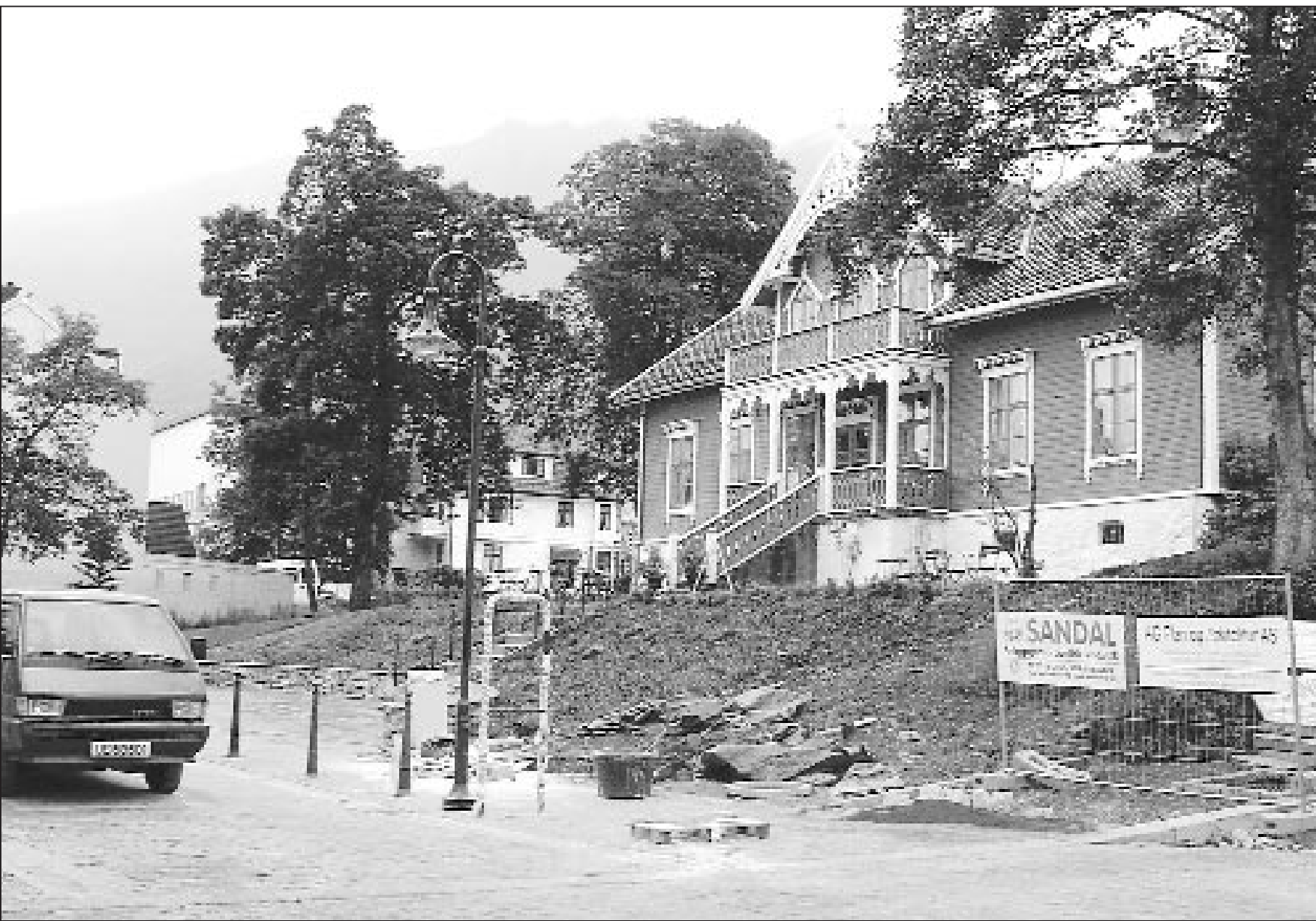
Arbeidet med hageanlegget framfor Svendsengarden er i innspurten.
