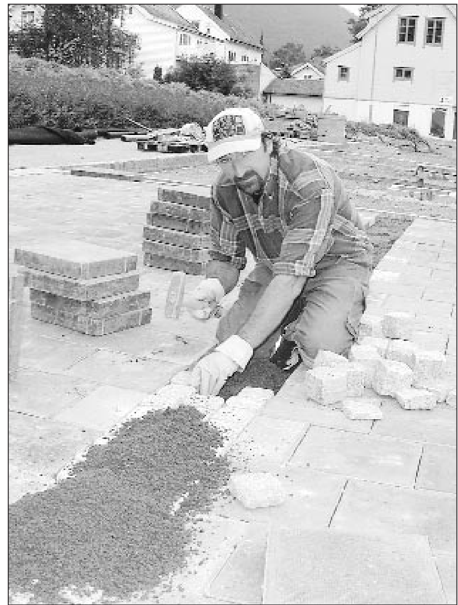
Jon-Arve Lillemark driv steinlegging i Vikegata, som vert ferdig innan 10. september.
